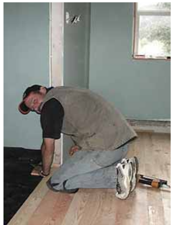
Jens Kugelstadt laying bedroom floor
